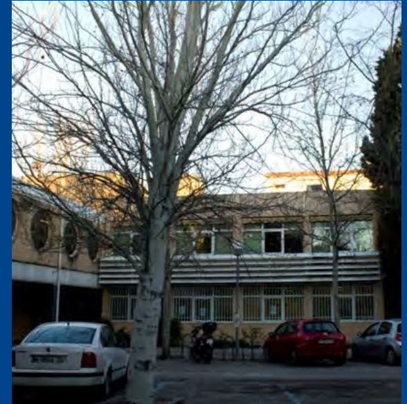
Escuela Técnica Superior de Ingeniería y Sistemas de Telecomunicación (2013)
